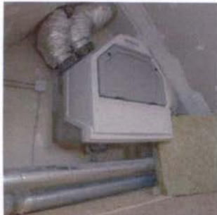
een warmte-balanstoestel dat de warmte van de afgevoerde lucht recupereert
